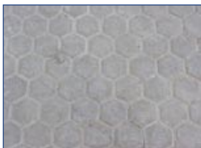
Fig.: 22. Pavimento de loseta hidráulica
