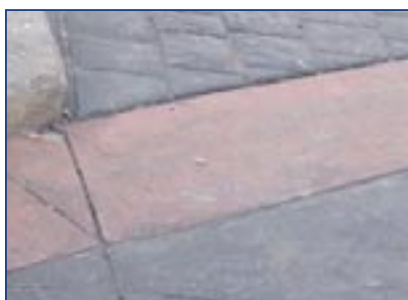
Fig.: 29. Pavimento de hormigón impreso
